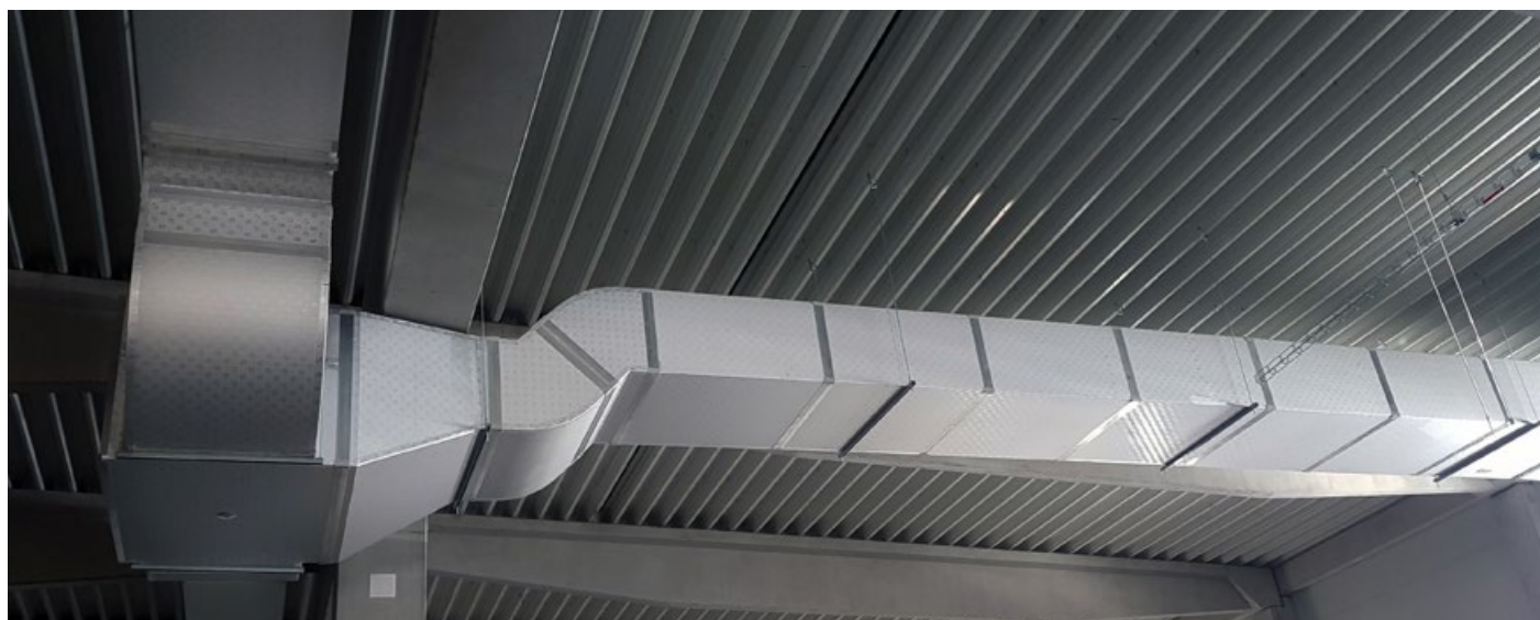
Interiérové provedení pro odlehčení nosným konstrukcím.
