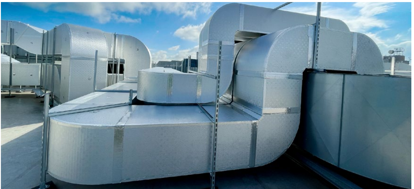
Exteriérové potrubí s nárokem na nízké zatížení nosné konstrukce.
