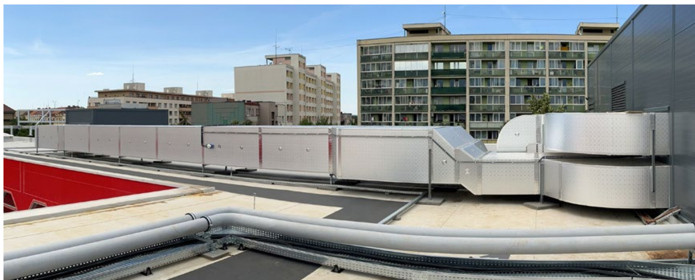
Modernizace vzduchotechniky v rámci rekonstrukce obchodního objektu.
