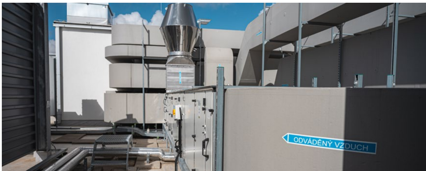
2 000 m 2 panelů P3 Resistant + 7 000 m 2 panelů P3 – Piral HD Hydrotec Outsider
