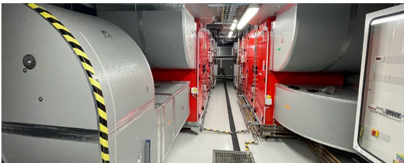
Řešení pro strojovnu aquaparku: 20mm panely a PVC příruby pro zvýšenou odolnost proti korozi.
