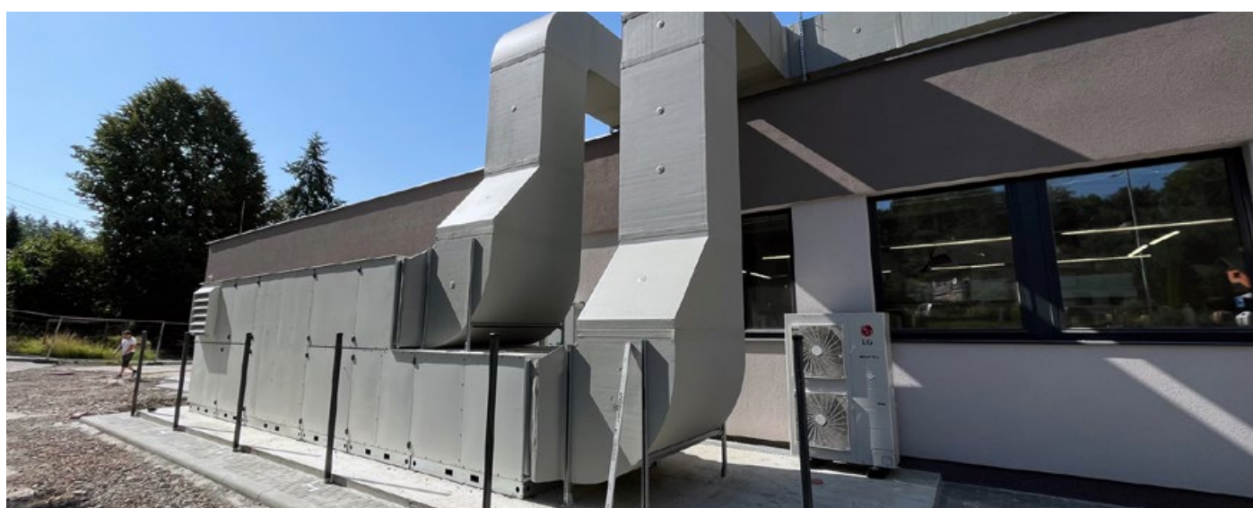
Přístavba MŠ – exteriérové potrubí s povrchovou ochranou GumSkin.
