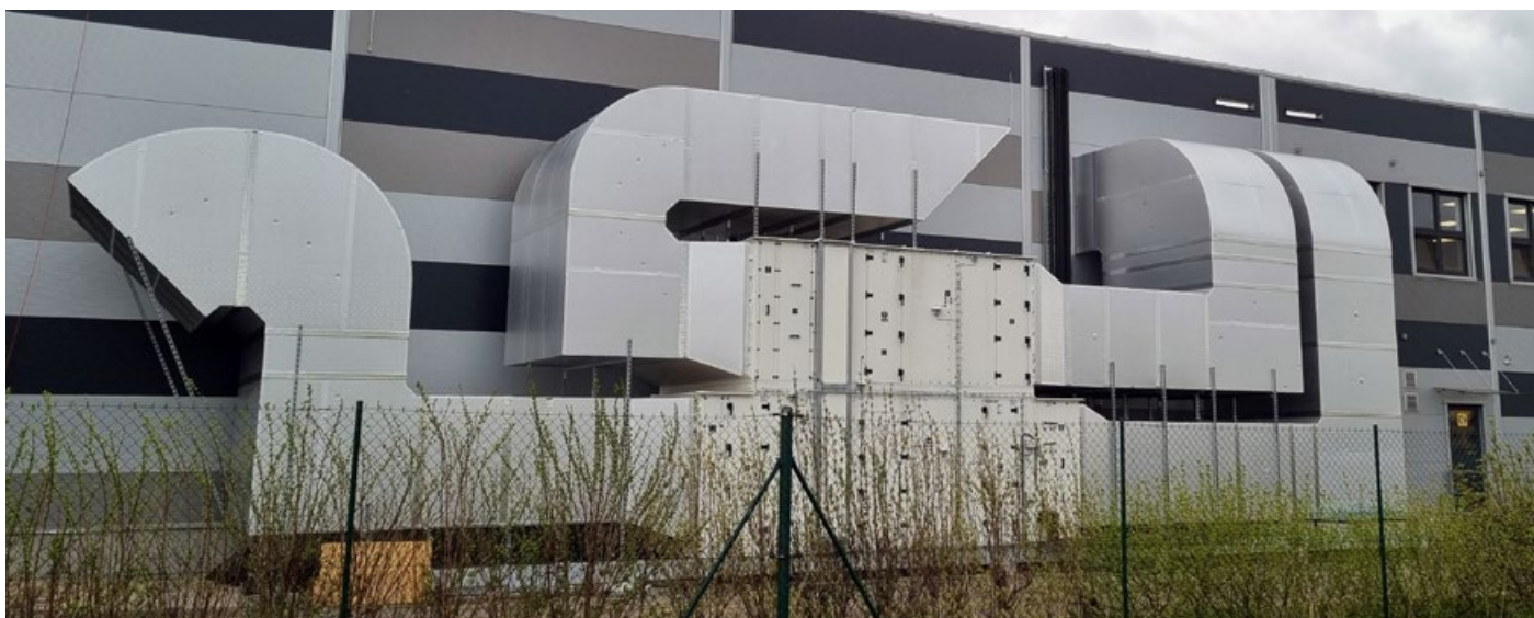
Přístavba haly s použitím exteriérového potrubí.
