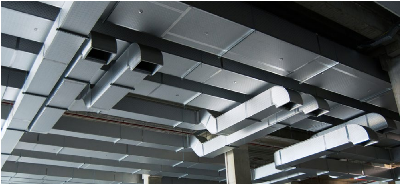
Realizace interiérových rozvodů ve výrobní hale.
